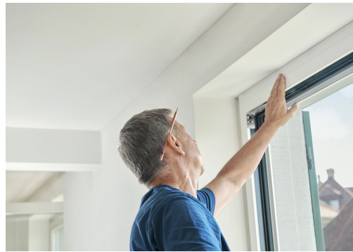
Montage eines neuen Fensterrahmens
