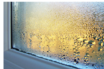
Ill. : Condensation sur l'extérieur de la fenêtre
