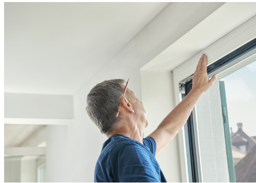
Montage eines neuen Fensterrahmens
