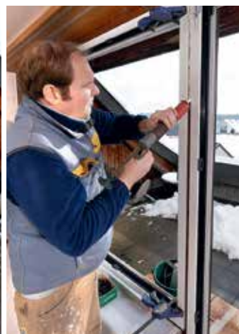
Hohlräume werden abgedichtet.
