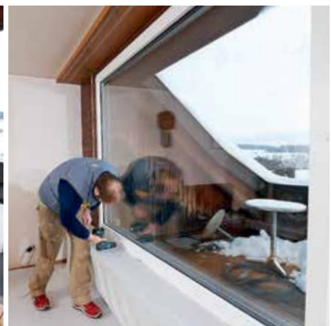
Der eingesetzte neue Fensterflügel wird fixiert.
