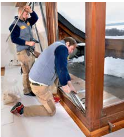
Der alte Wetterschenkel wird entfernt.
