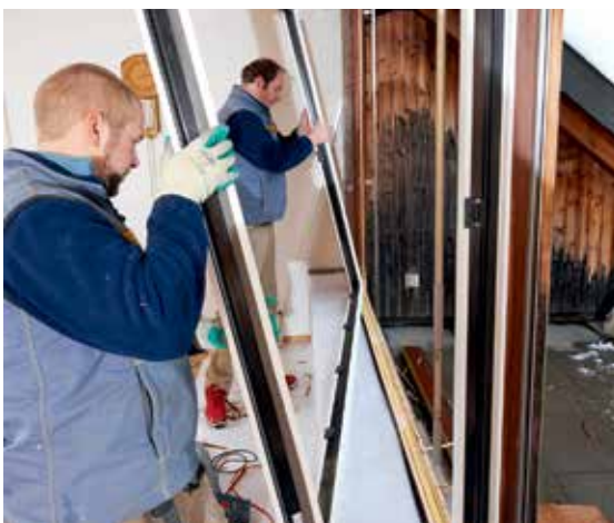
Der neue Fensterrahmen wird eingebaut.
