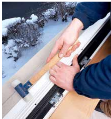
Fixieren eines neuen Wetterschenkels.
