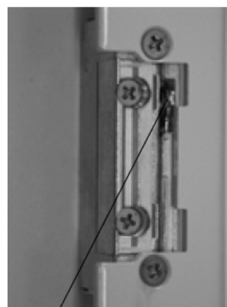
Schieber für den Wechsel zwischen Normalstellung und Tagentriegelung
